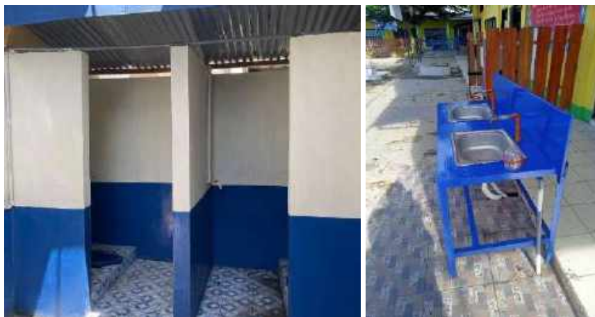
Gambar 3. Penambahan toilet dan tempat cuci tangan baru di lingkungan pesantren.
