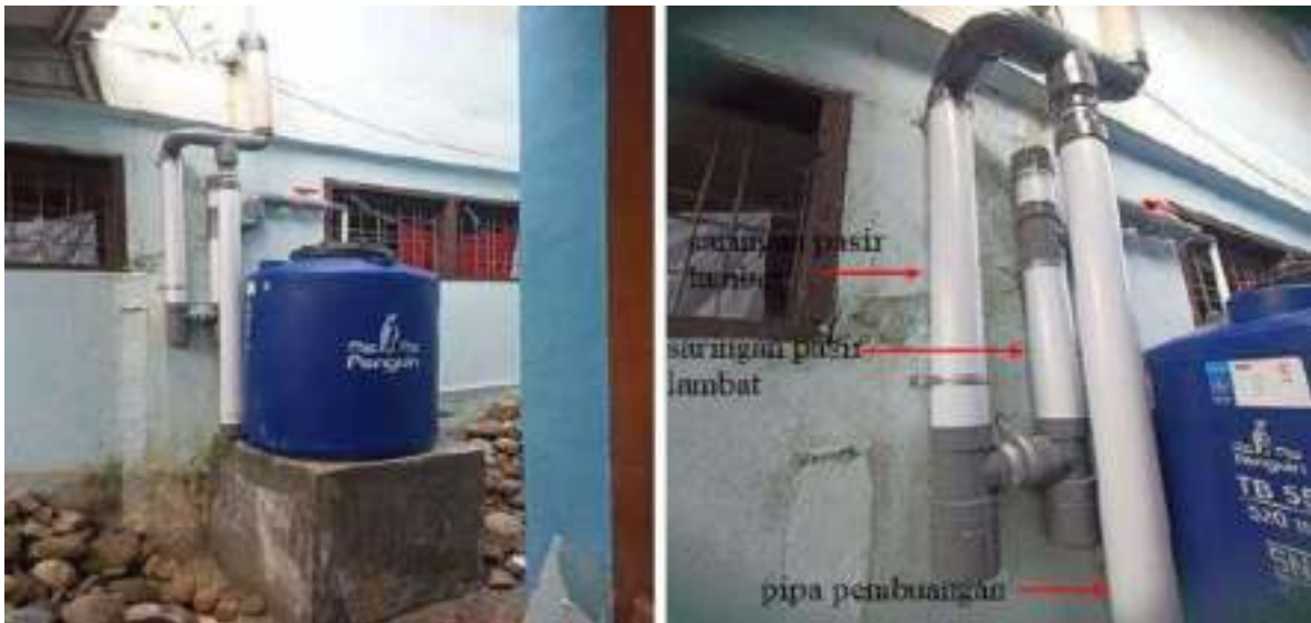
Gambar 3.2. Alat Filter Pemanenan Air Hujan
