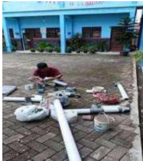
Gambar 4.1 Proses pembuatan kerangka filter
