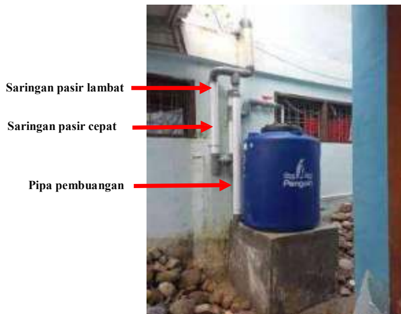
Gambar 4.3 Filter Pemanenan Air Hujan
