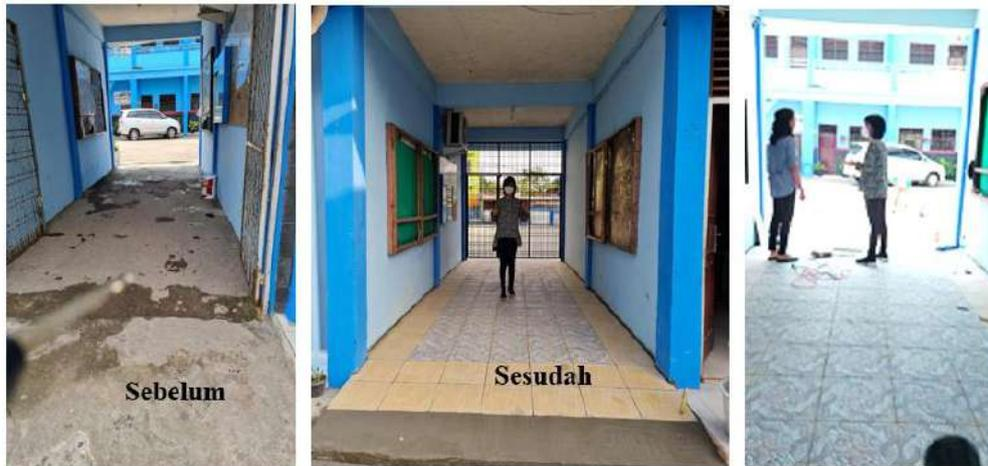
Gambar 4.6 Renovasi lantai, pengecoran dan pemasangan keramik
