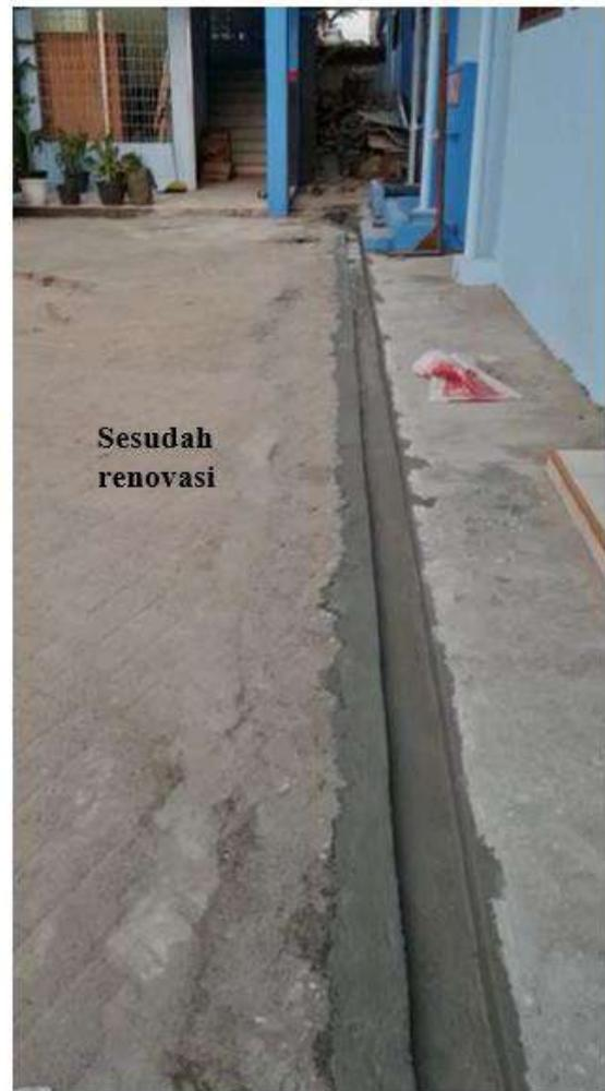
Setelah perbaikan, saluran limbah menjadi bagus. Aliran limbah menjadi lancar. Kegiatan juga meliputi pembersihan saluran air dan pembongkaran sampahsampah yang menghambat jalannya aliran. Kegiatan lainnya adalah membongkar paving blok yang celahnya tertutup sehingga bila terjadi hujan, air tidak cepat meresap yang menyebabkan banjir atau genangan air di sekitar sekolah.
