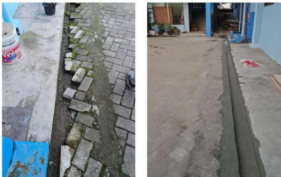
Gambar 4.1 Kegiatan perbaikan saluran air
