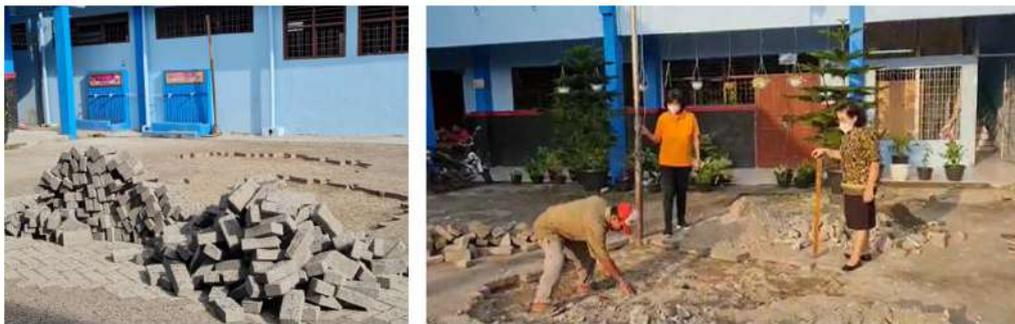
Gambar 4.4 Pembongkaran paving blok
