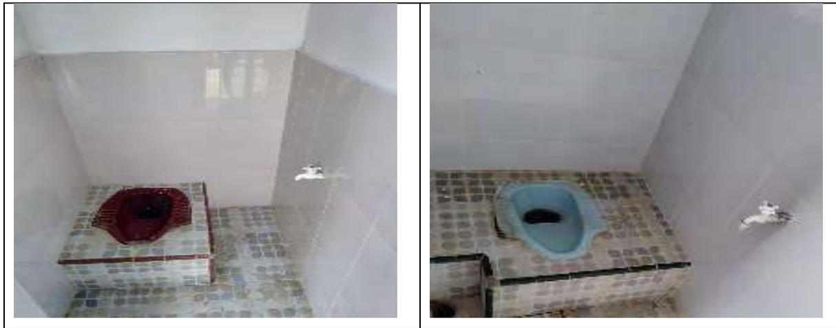
**Gambar 4.2. Kondisi kamar mandi setelah pemasangan keramik di dinding**
