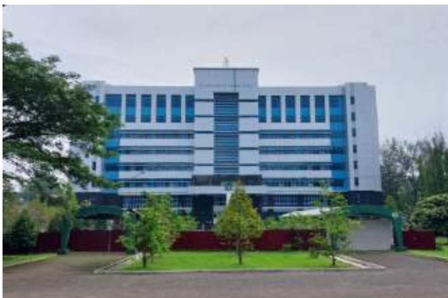
Gambar 14. Tampak Depan Pembangunan Digital Learning Center Building
